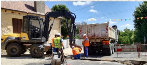
Tranchée d'enfouissement de câbles pour le nouveau réseau électrique basse tension et Télécom
